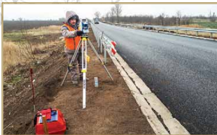
Під час виконання розмічувальних робіт
