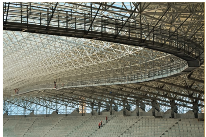
Будівництво стадіону «Арена Львів»
