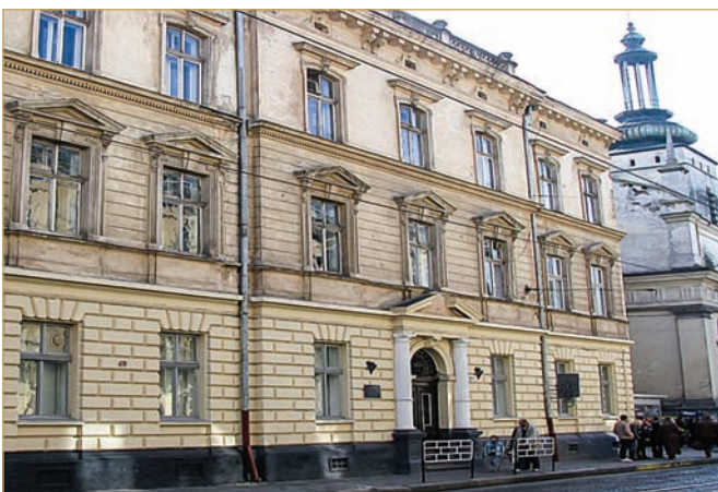
Навчальний корпус Львівського автомобільно-дорожнього коледжу
