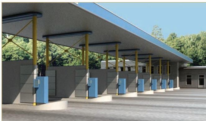
Автомобільна газонаповнювальна компресорна станція
