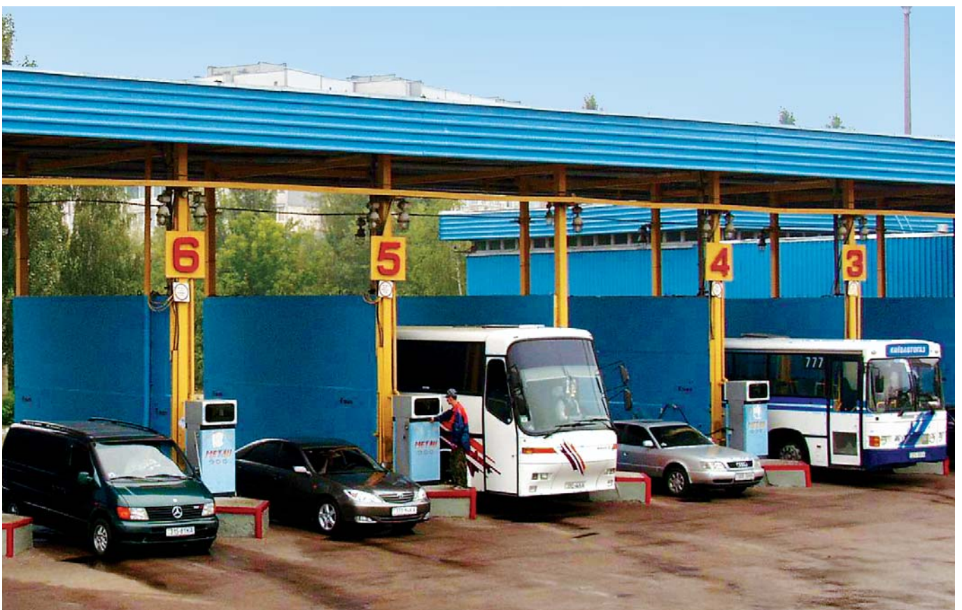
Автомобільна газонаповнювальна компресорна станція
