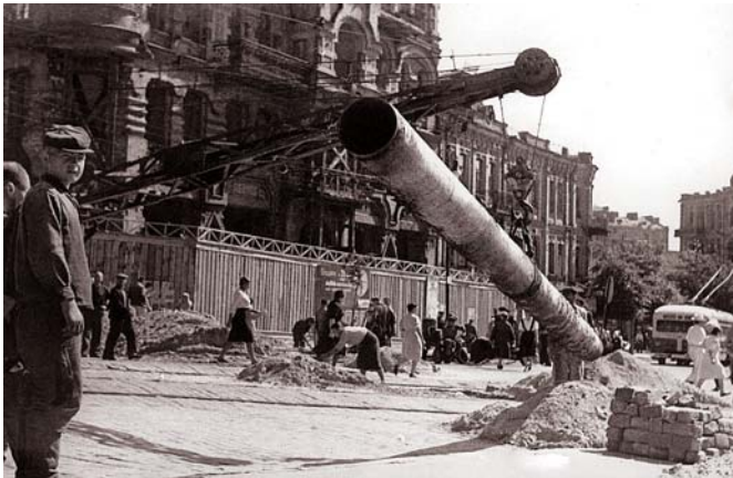
Прокладання газопроводу в Києві, 1948 р.
