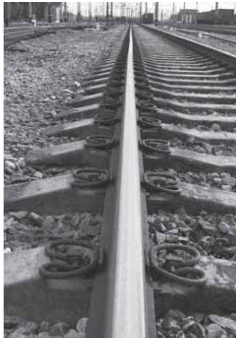
Пружне рейкове скріплення типу PRR
