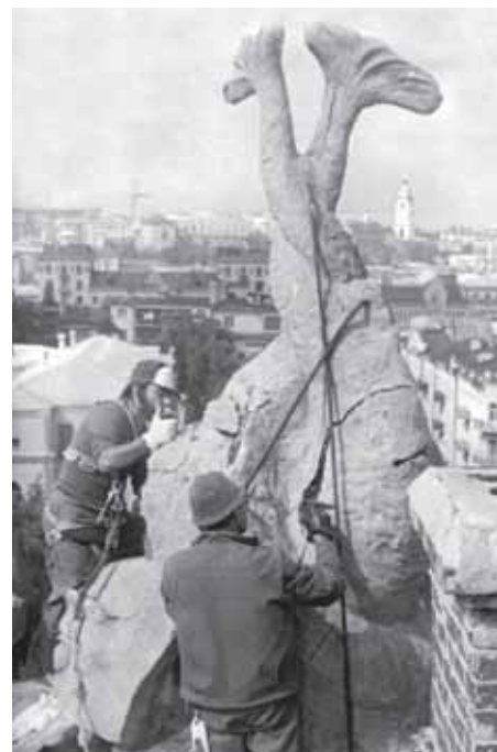
Відновлення міцності бетонної «хімери» мікроін'єктуванням клеєвого полімерного складу
