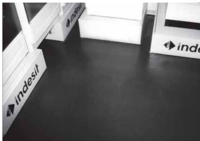
Поліуретанове покриття підлог у магазині побутової техніки
